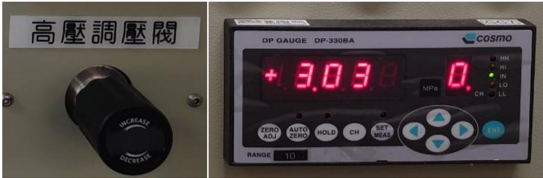
圖7 高壓調壓閥及壓力錶
