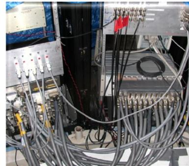
利用資料擷取系統傳達變電所量測資料，但有頻寬限制
